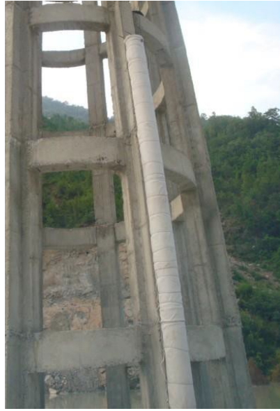
溢流井库水位安装实景图
