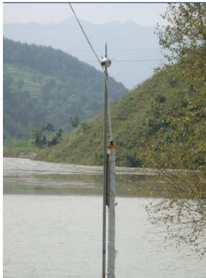
排水斜槽库水位安装实景图
