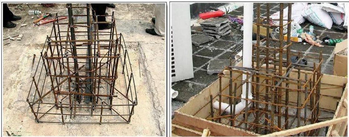
观测墩施工实景图
